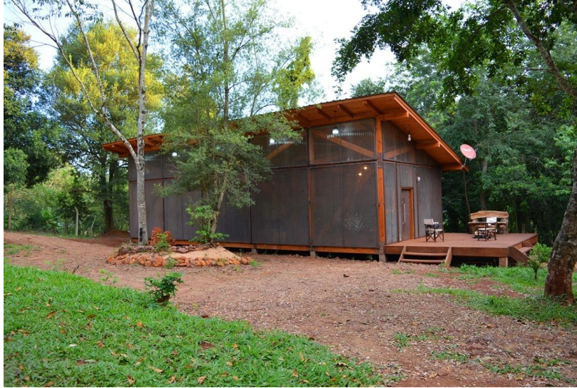
ARQA – Refugio Naturalis – Foto ENNE Arquitectura.
